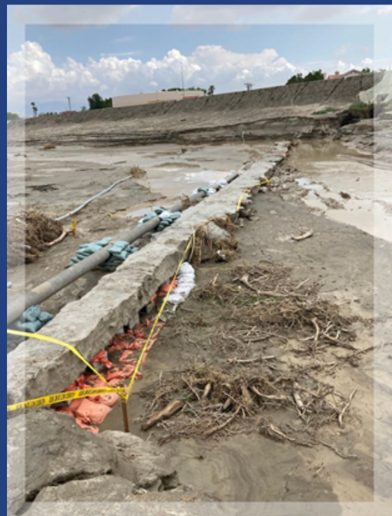
Vista hacia el este, mostrando el depósito de Indio Water Authority (IWA) en la parte superior del terraplén. Junto a nuestra tubería principal de alcantarillado revestida de hormigón (estructura rectangular) está la tubería de agua de la IWA, también expuesta durante la tormenta inicial del 14 de febrero de 2019.
